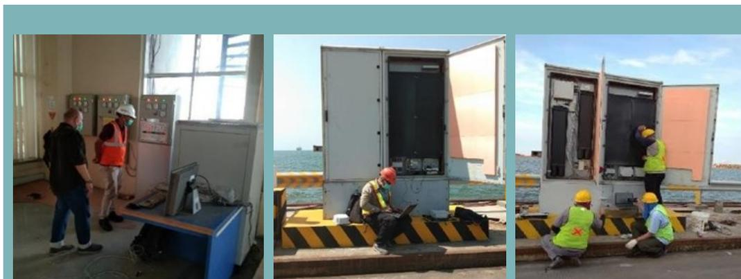
*Gambar 115. Perawatan RPM di Terminal Petikemas Semarang*
